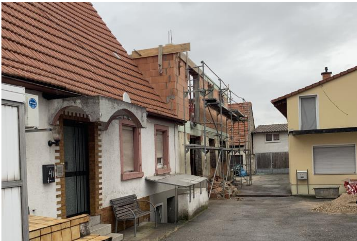
Abb. 8: Neu- und Umbaumaßnahmen in zweiter Reihe in der Hauptstraße (Foto: bhm)
