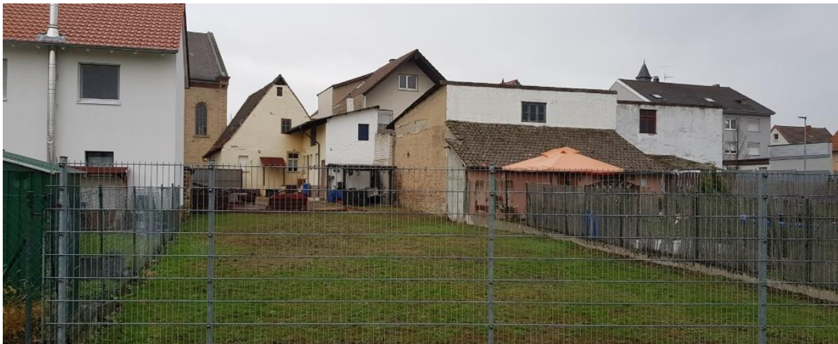
Abb. 5: Rückwärtige Bebauung der Kirchstraße (teilweise umgebaut o. erneuert)
