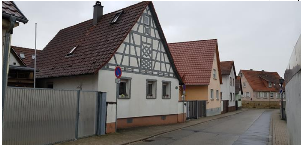
Abb. 6: Ortstypische Haus-Hof-Bauweise entlang der Hauptstraße
