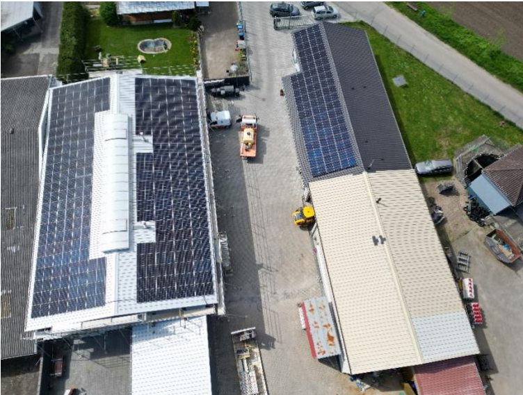
Bauhof Kronau mit Photovoltaik der BEG (© Foto: BEG Kraichgau)
